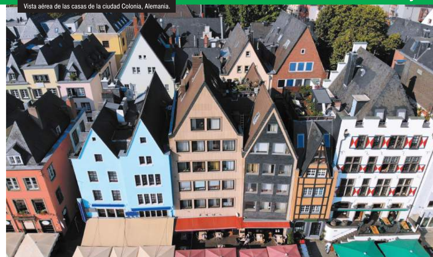
Vista aérea de las casas de la ciudad Colonia, Alemania.
